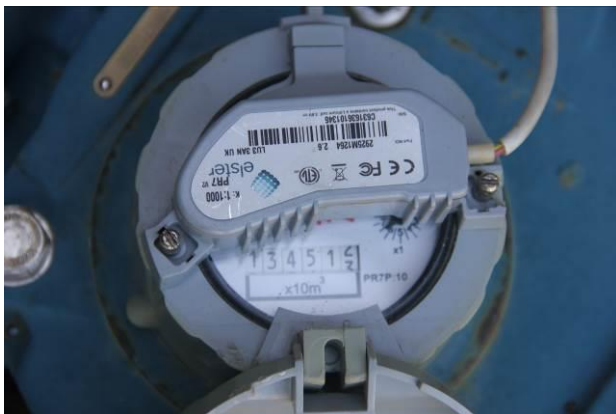
Voorberg reservoir outlet (Buffels River)
